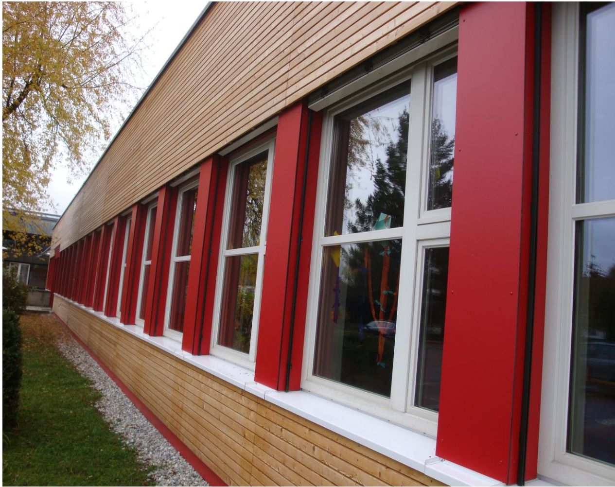
小学校／ドイツ 築45年の建物を断熱リフォーム Lueckenfassade / Schule
