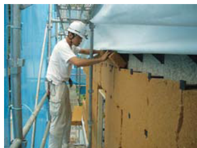
ホームテルムの木質断熱材 10cm厚の断熱材を外側から施工
